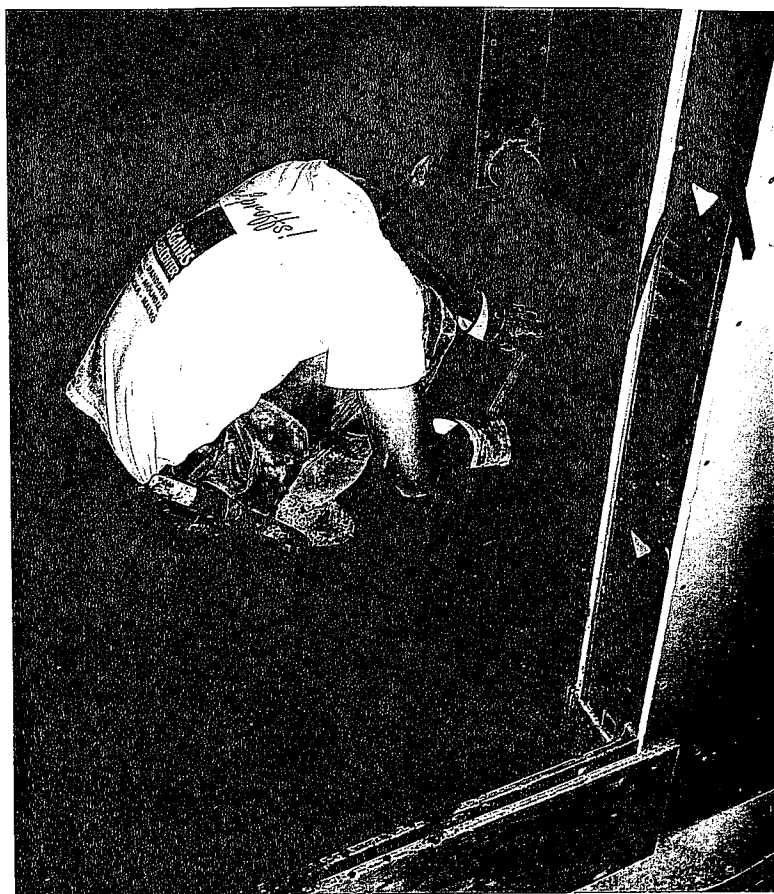
Finjustering av yta och nivåer med sloda, laser och rätskiva.
