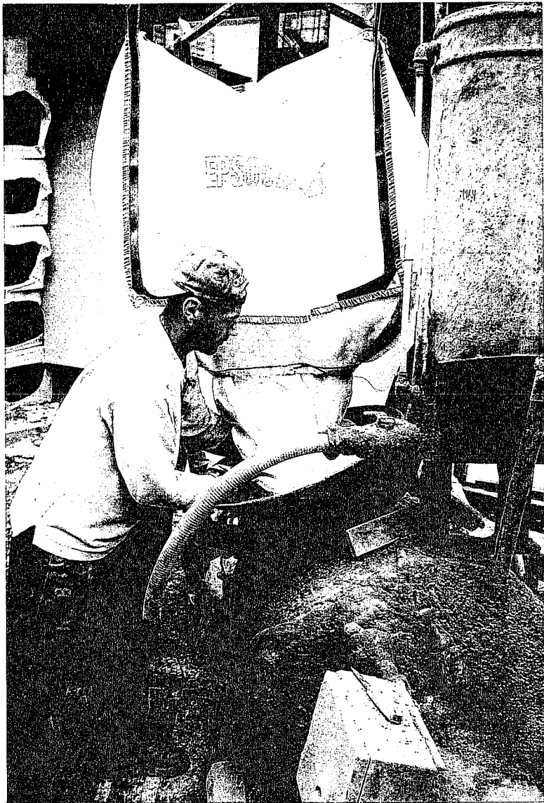
Tvångsblandare med Spiralskruv fylls på platsen med expanderad polystyren, cement och vatten
